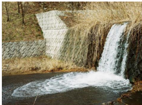
砂防ダム改修前(2008年)
